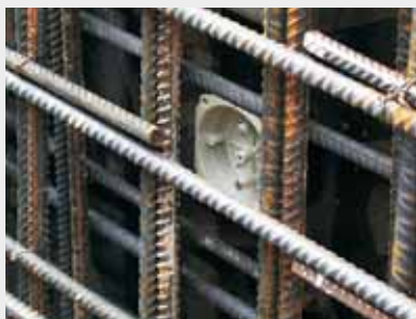
Víčko KBV připevněné na bedněni.
