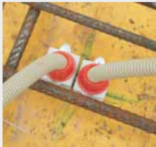
Příklad použití vývodky a koncovky.
