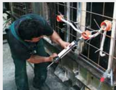
Utěsnění vstupů (tmel).
