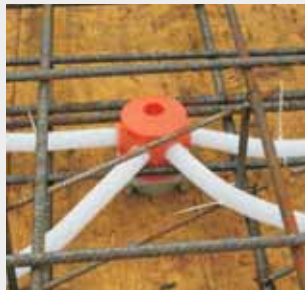
Příklad použití na horizontální bedněni.
