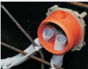
Namontované ohebné trubky do tělesa KBT.
